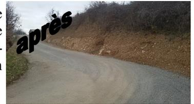
**Route des Graves** : Le contournement de l'effondrement a été finalisé avec la réalisation d'une nouvelle chaussée déportée de 4 mètres par rapport à l'ancienne et des balises ont été posées.
